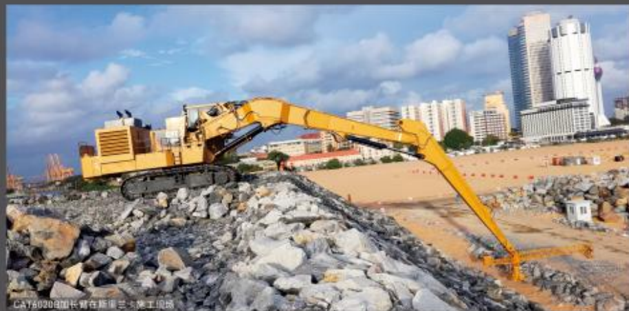
CAT6020加长臂在新加坡施工现场
